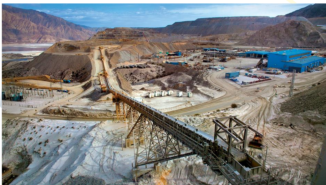
(Construcción y montaje de equipos de las áreas de trituración y separación de mineral)
